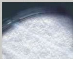
Обмерзание теплообменника
